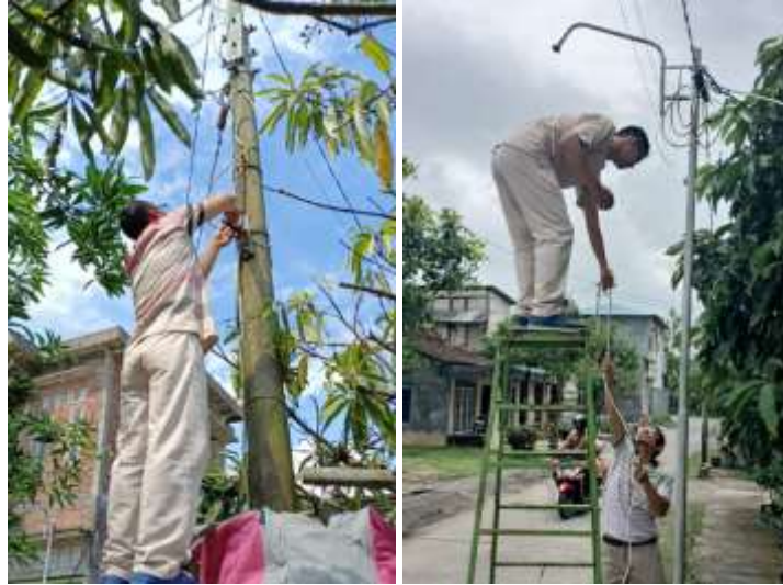
Gambar 2. Pelaksanaan pemasangan instalasi lampu PJU
