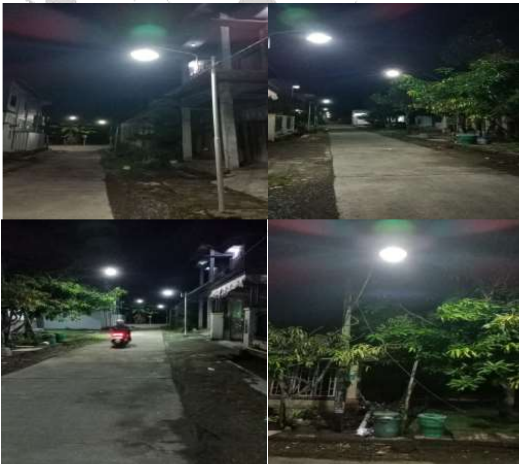
Gambar 3. Kondisi jalan setelah pemasangan lampu PJU pada malam hari
