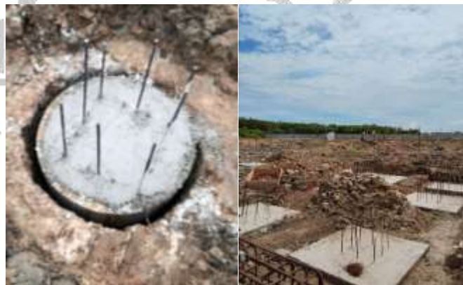
Gambar 6. Pondasi Sumuran dan Lantai Kerja
