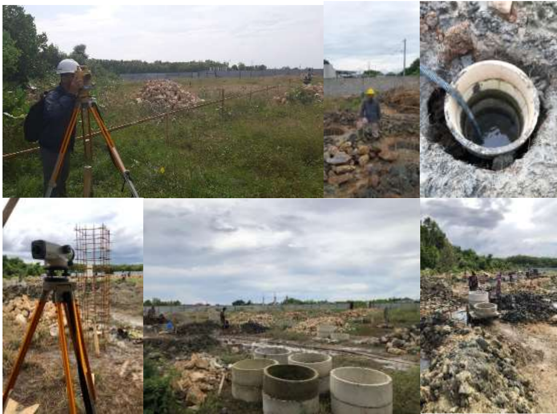
Gambar 5. Pelaksanaan Pekerjaan Pondasi Sumuran
