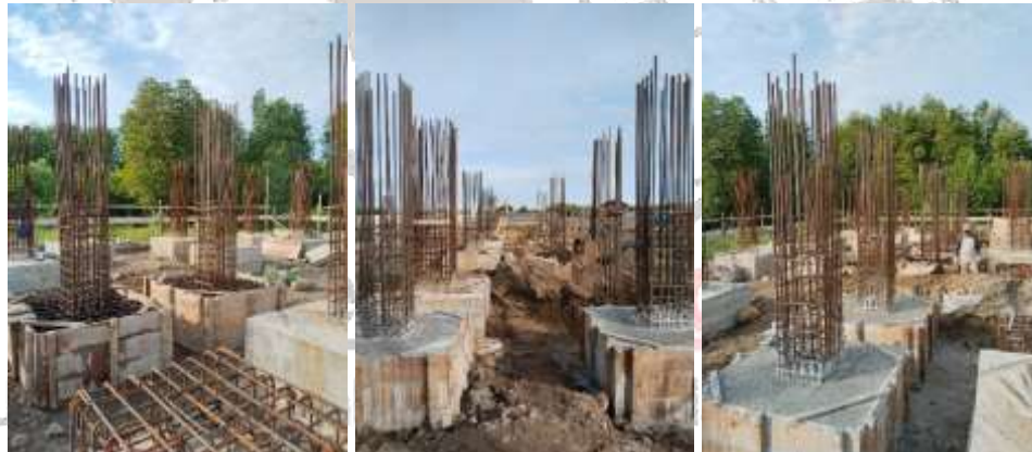
Gambar 6. Pelaksanaan Pengecoran Pondasi Tapak
