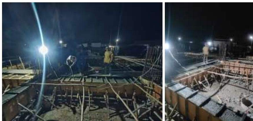
Gambar 7. Pelaksanaan Pengecoran Balok Sloof
