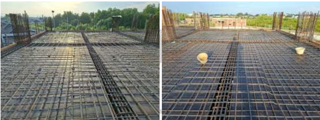
Gambar 11. Pembesian Plat Lantai 2 Yang Telah Selesai
