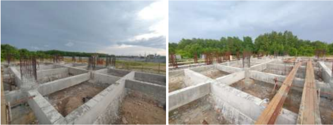
Gambar 10. Balok Sloof Yang Telah Selesai
