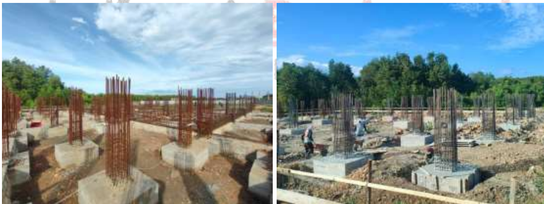
Gambar 9. Pondasi Tapak Yang Telah Selesai
