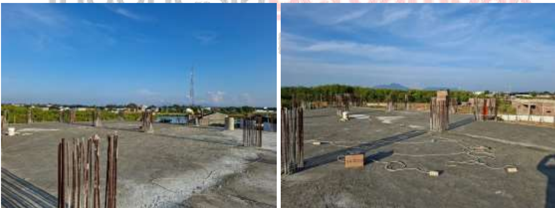
Gambar 12. Plat Lantai 2 Yang Telah Selesai
