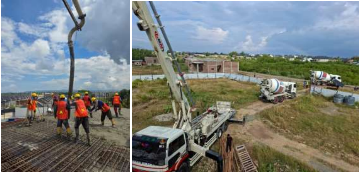
Gambar 8. Pelaksanaan Pengecoran Balok Lantai 2 dan Plat Lantai 2
